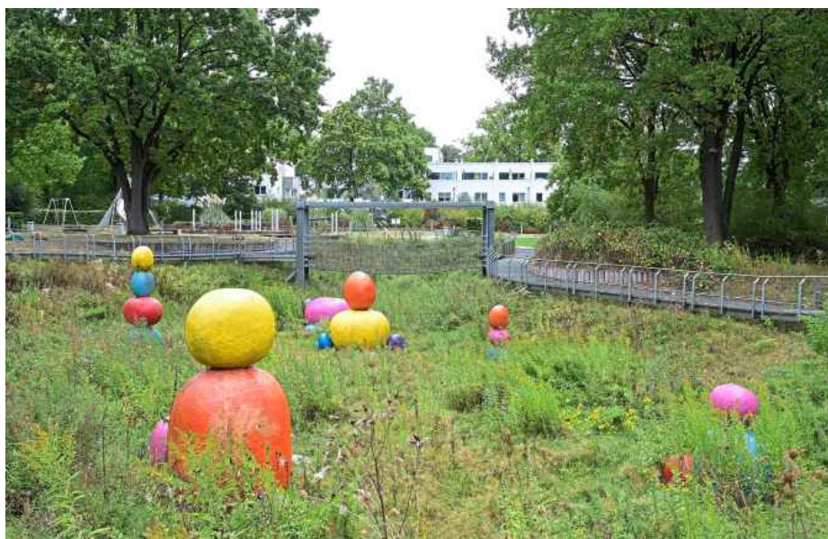
Anpassung an Klimawandel in Hamburg-Nord: SAGA Wohnquartier „Am Weißenberge“ mit Regenwasserabflüssen zu einem Regenrückhaltebecken.
