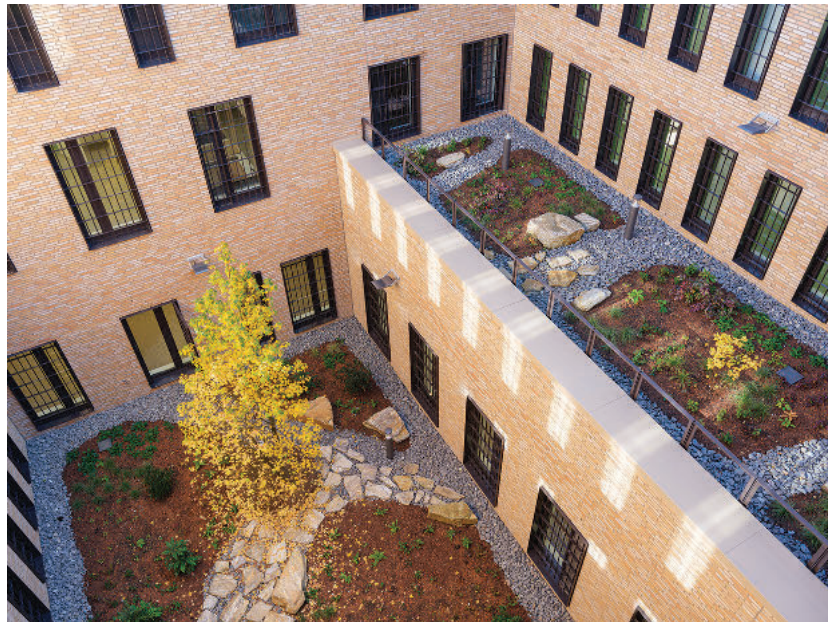
Abb. 3: Klimastrategische Gestaltung der Dachflächen und Innenhöfe; Foto: Stefan Müller-Naumann
